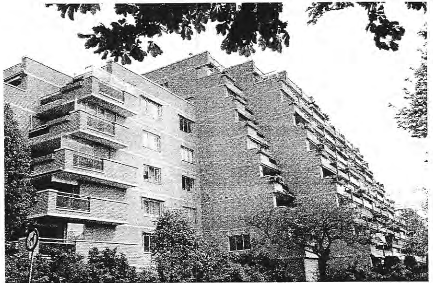
De trapsgewijze opbouw van het appartementencomplex zorgt ervoor dat elk appartement weer anders is van afmeting.
