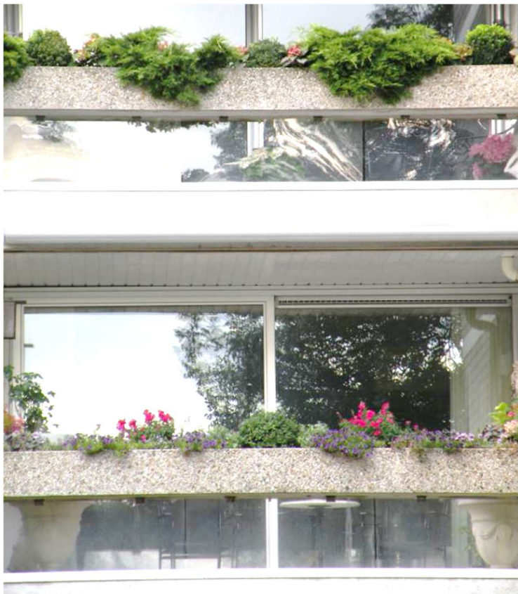
Het is toegestaan om de betonnen plantenbakken op de balkons en de zeembalkons te voorzien van planten tot een max. hoogte van 50 cm.
