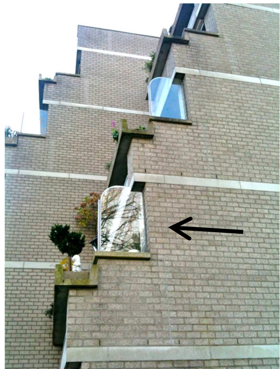
De windschermen met ronde bovenkant op de eindbalkons van Fase 1.
