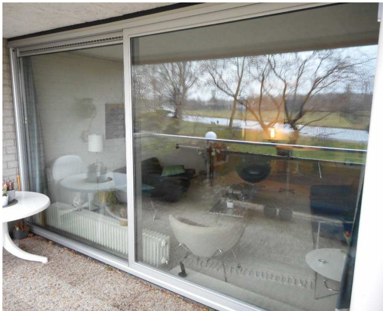
Kozijn bij balkon.
